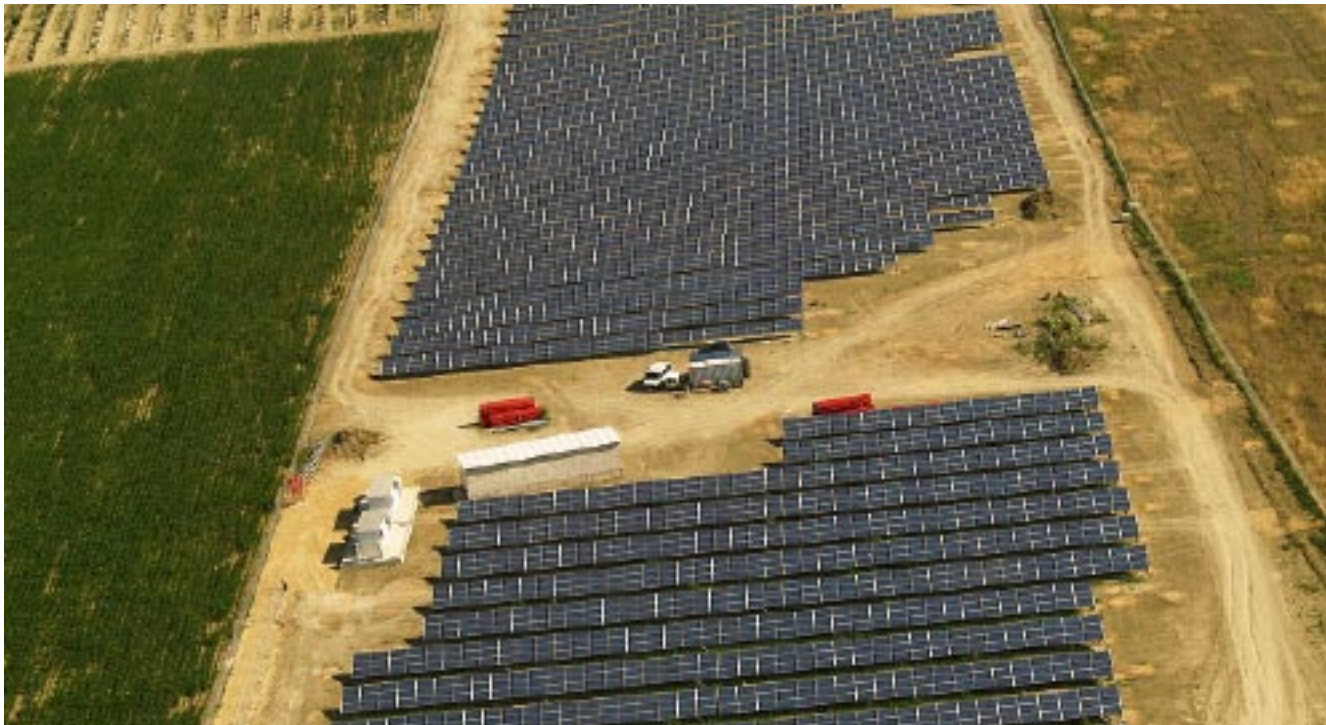
Die Leistung des Solarkraftwerks im spanischen El Trujillo wurde im vergangenen Sommer von 1,1 auf 1,28 Megawatt erhöht.
